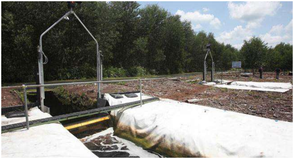
Sumber: Kecamatan Bukit Batu, 2016 ( https://camatbukitbatu.bengkalis.kab.go.id/ ) Gambar 13. Model telematic watergate and loggers di lahan gambut
